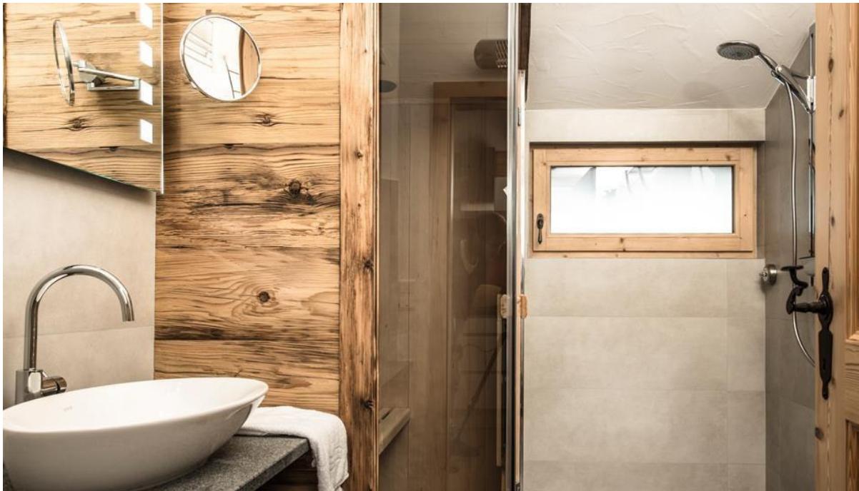
großformatige Wandfliesen im Bad
