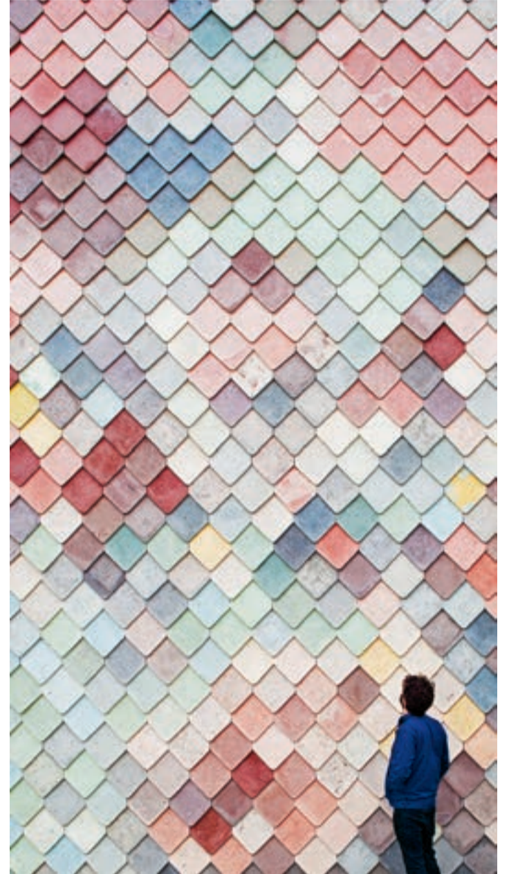
Die Keramikfassade des Yardhouses im Osten Londons wurde zum Landmark. Foto: Assemble
