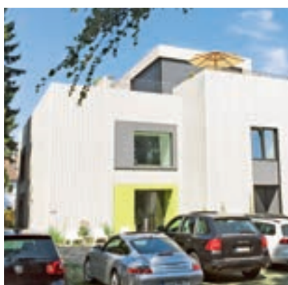
Außen gelochtes Trapezblech, innen großzügige Wohnungen: Ein Hauch von Manhattan weht seit zwei Jahren durch Essen-Huttrop.
