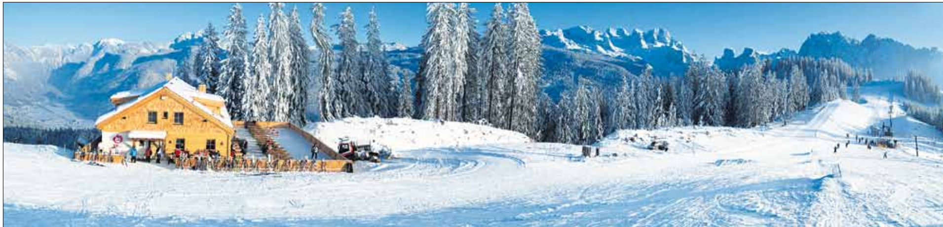
Skihütte Hornspitz: Dank Baurecht deutlich bessere Verwertung gegenüber der Nutzung der Waldfläche.
